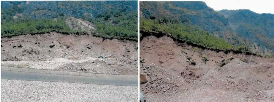
Figura 6-20 Foto nga sheshi i shfrytëzuar për nxjerrjen e inerteve për ndërtimin e rrugës.
